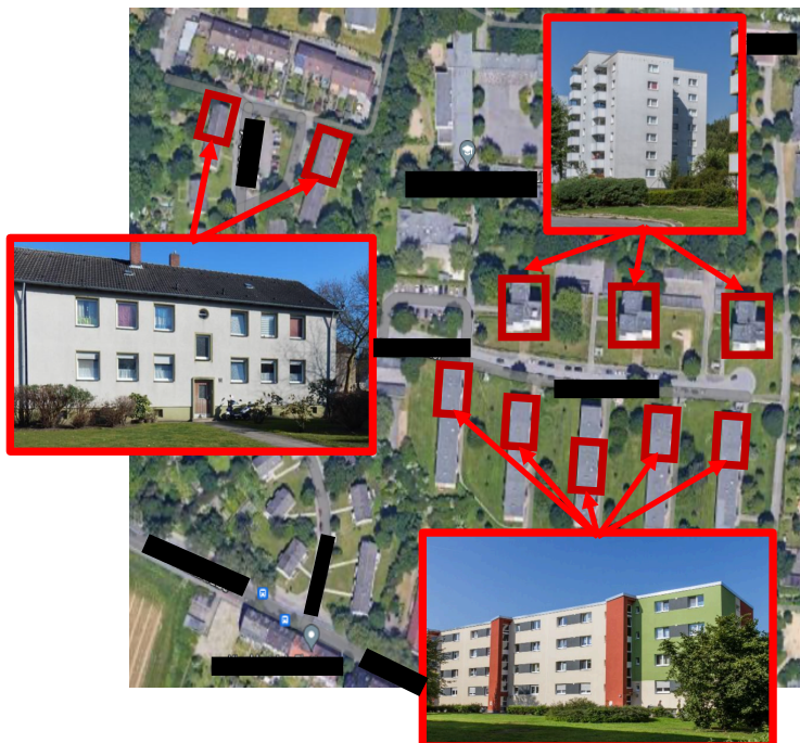
Abb. 13: Lage und Bauart der Liegenschaften H & S Projekt FWU Pilotphase I
